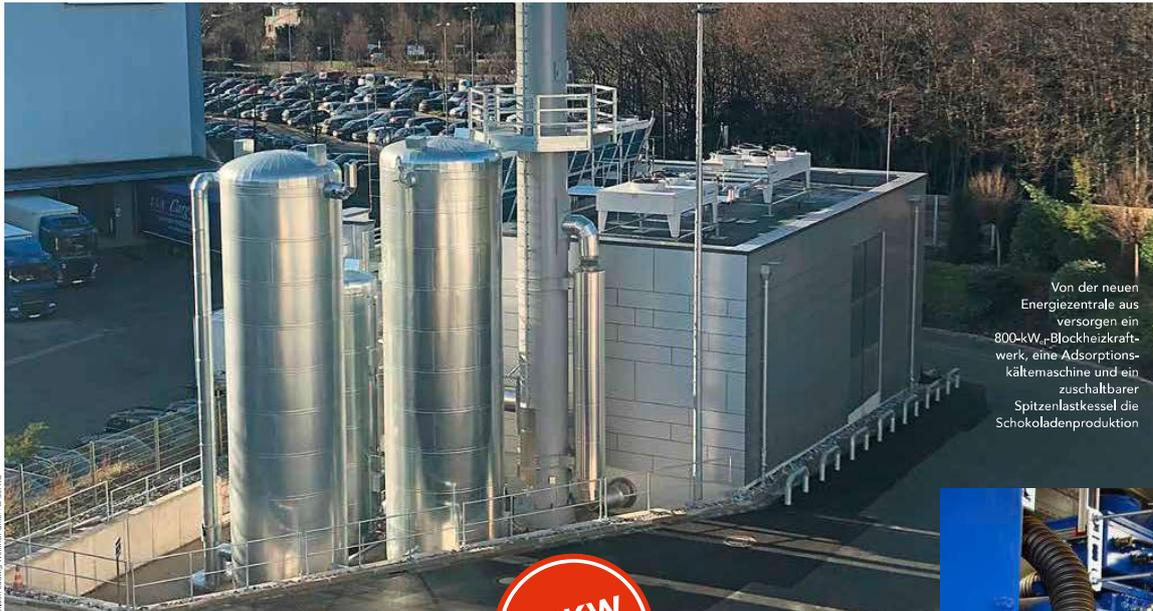
Von der neuen Energiezentrale aus versorgen ein 800-kW-Blockheizkraftwerk, eine Adsorptionskältemaschine und ein zuschaltbarer Spitzenlastkessel die Schokoladenproduktion
