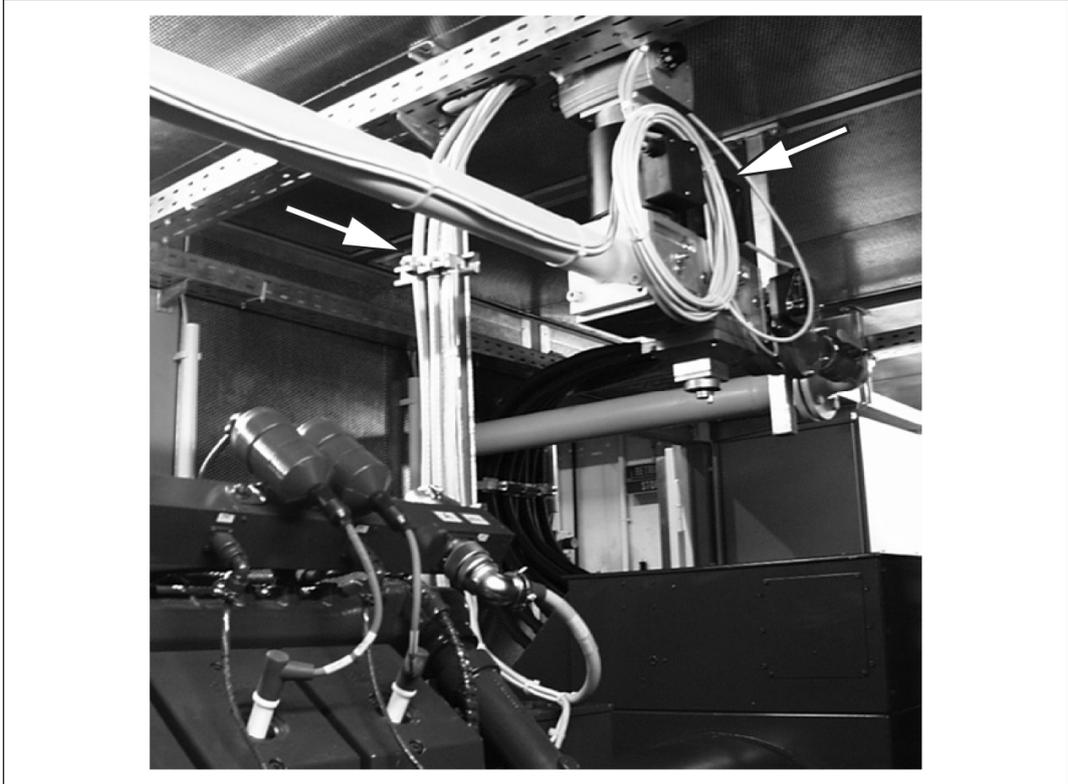
67248-001 Senkrechter Kabelabgang der Motorverkabelung
