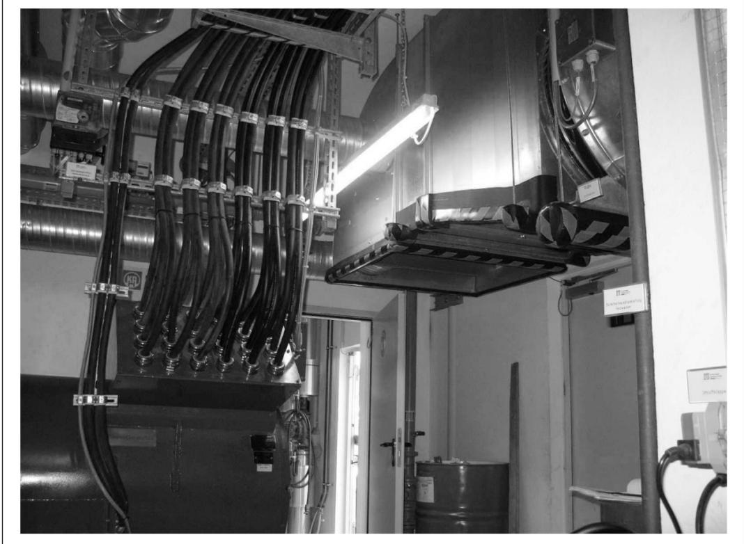
67260-001 Beispiel mit korrekter Kabelverlegung mit Halterungen
