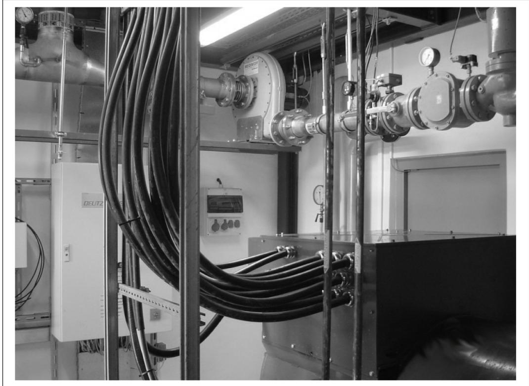
67261-001 Beispiel mit inkorrekt er Kabelverlegung, nicht kurzschlussfest
