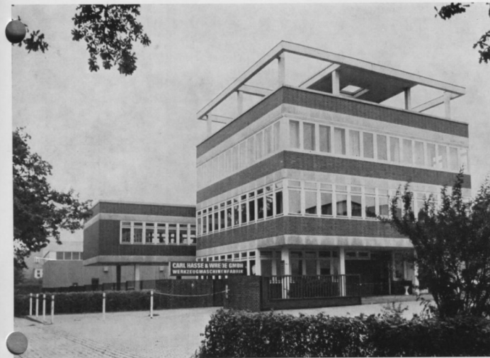
◀ Die Carl Hasse & Wrede GmbH, Berlin — Werkseinfahrt und Verwaltungsgebäude
