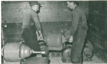
FROHER: Verladen von Bremszylindern im Waggon in Handarbeit. Schwere körperliche Arbeit, da großes Einzelstückgewicht
