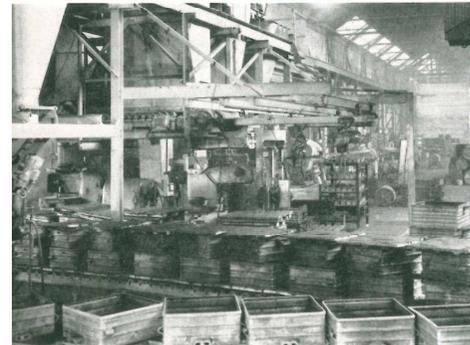
Bild 5: Sandbunker über den Formmaschinen für die Rollbandfertigung
