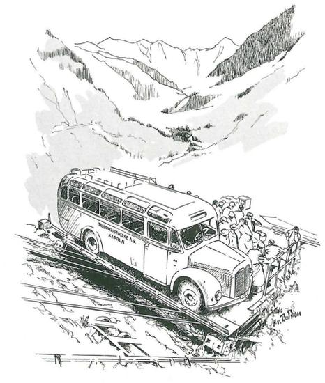
Der Schrägaufzug „Lärchwand“ befördert Nutzlasten bis zu 60 t
