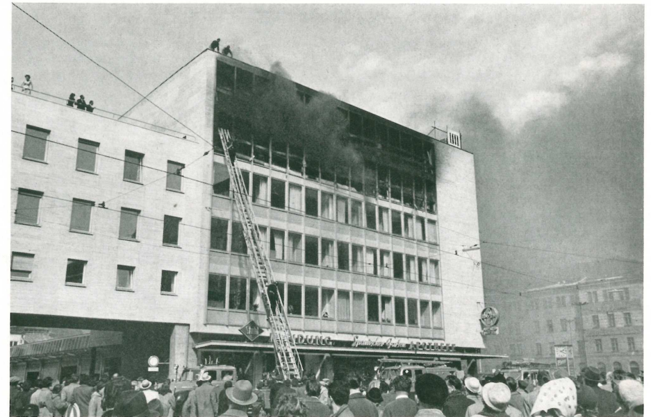
Der Münchener Hauptbahnhof in Flammen
