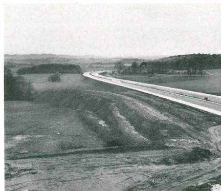
Dammaufschüttung mit nachfolgender Bepflanzung
