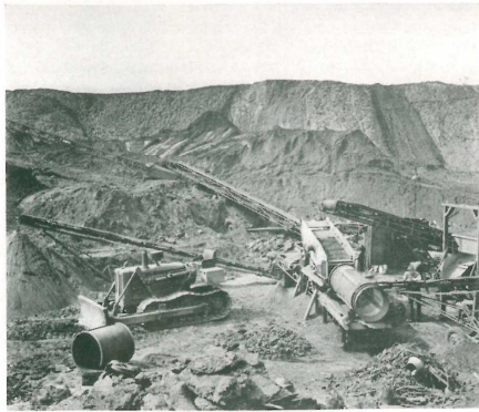
Teilansicht der Aufbereitungsanlage
