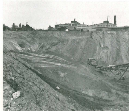
Arbeiten zur Neuanlage der Kippe
