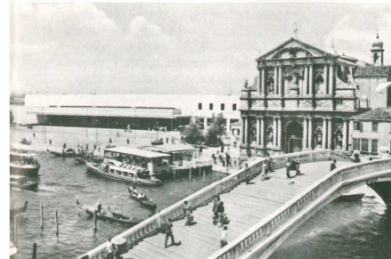
Barfüßlerkirche und Bahnhof
