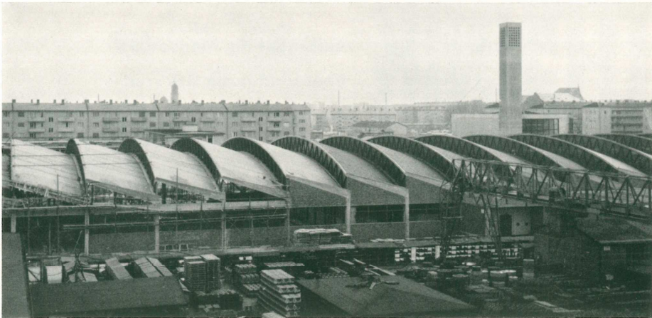
Werkhalle an der Max-Joseph-Straße, Ansicht vom Werksgelände
