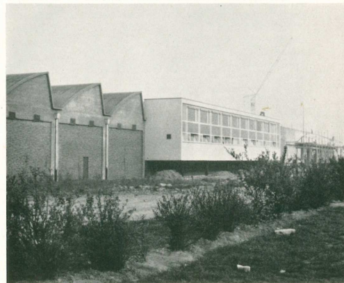
Werkhalle an der Max-Joseph-Straße, Teilsicht von der Straßenseite
