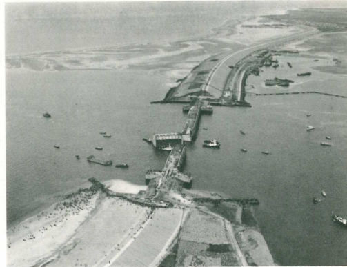
Bauarbeiten am Zandkreekdamm
