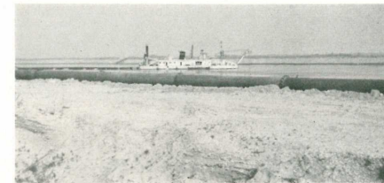
Wohin das Auge schaut: Sand und Wasser, Bagger und Rohre
