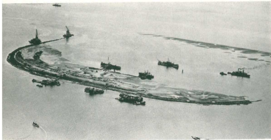
Die einzelnen Phasen der Baugrube ...
