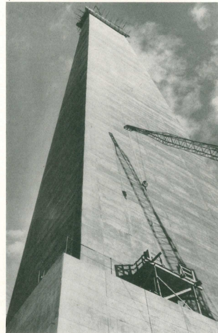
Pfeiler II ist mit seinen 147 m der höchste Pfeiler. Das Fundament ist 37 m tief
