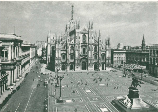
Der großartige Domplatz. Links davon befindet sich das Warenhaus La Rinascente (mit einem MWM-Notstromaggregat)
