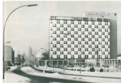
Berliner Hilton-Hotel mit MWM-Notstromaggregat
