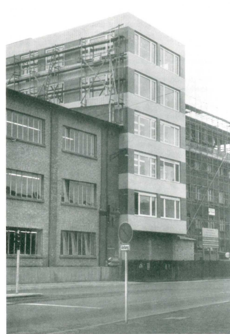
Der sechsstöckige Bau geht seiner Vollendung entgegen
