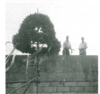
Der Richtkranz krönt den Rohbau
