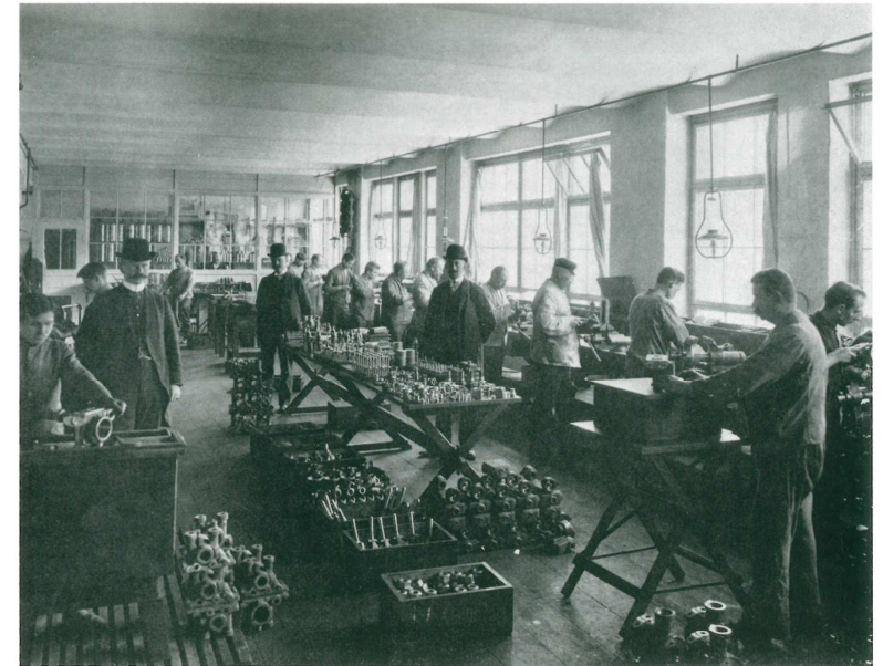
Montagwerkstatt für Bremsventile
