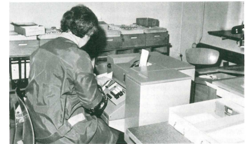
Datenerfassungsgerät im Materiallager der Südbremse
