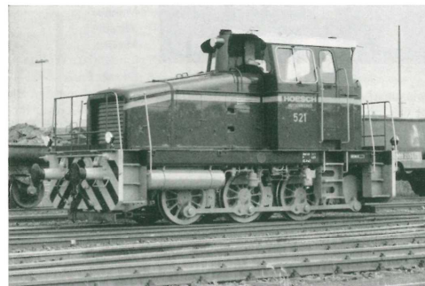
500 PS-Diesellokomotive, hergestellt von Kraus-Maffai, umgebaut auf Funkfernsteuerung von der Hoesch AG
