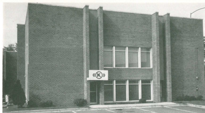
Das Gebäude der Knorr Brake Corporation in Rockville
