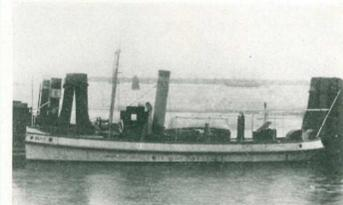
Vor 65 Jahren, am 15. März 1912, schoß ein Amateurfotograf dieses Foto. Was da auf der Elbe — vor dem Hamburger Hafen — am Duedalben dümpelt, ist das MS „Benz“, das erste deutsche Schiff, das mit einem direkt umsteuerbaren Dieselmotor des Mannheimer Dieselmotorenwerkes ausgerüstet worden war. Es hieß damals noch „Benz & Co., Rheinische Automobil- und Motorenfabrik Aktiengesellschaft“. Fertigungsstätte war das Stammwerk der heutigen MWM auf dem Gelände an der Waldhofstraße 24-38.
