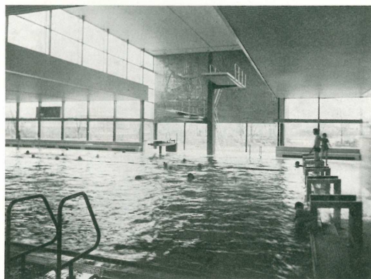
Motorenabwärme des BHKW beheizt Sporthalle, Sauna und Hallenbad; das Schwimmbeckenwasser als idealer Wärmespeicher!
