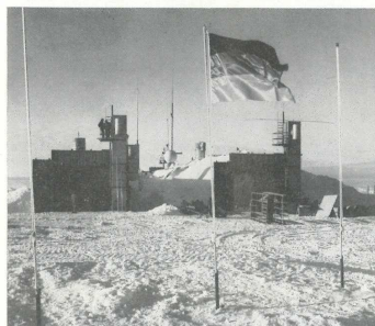
Station mit Flagge kurz vor Montage-Abschluß
