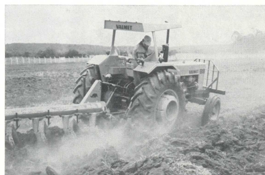
Vorführung eines Valmet-Schleppers, in den ein MWM-Zündstrahlmotor PID 229-4 eingebaut wurde
