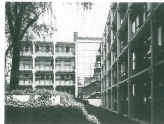
Verwaltungsgebäude der KB München aus Stahlbeton-Fertigteilen mit vorgehängter Fassade
