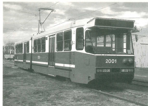
Melbourne's Straßenbahn. Neue Comeng-Prototypen bremsen mit Knorr-Druckluft
