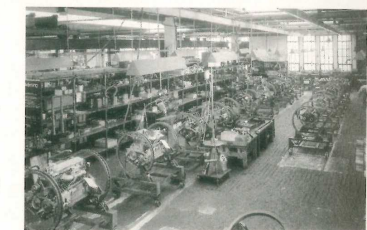
Serienmontage des 6-Zylinder-FORD-Hercules-Motors auf fahrbaren Montageeinrichtungen, in denen der Motor frei drehbar war. Vorbildliche ergonomische Gestaltung schon im Jahre 1949!
