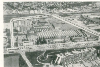
Längenvergleich eines UIC-Güterzuges (750 m) mit dem AAR-Abnahmezug (2300 m). Montage auf einem Luftbild des Firmengeländes der KB/SB München
