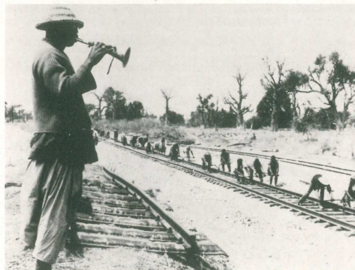
Beim Bau der Transkamerunbahn, an deren Kosten sich die Bundesrepublik beteiligte
